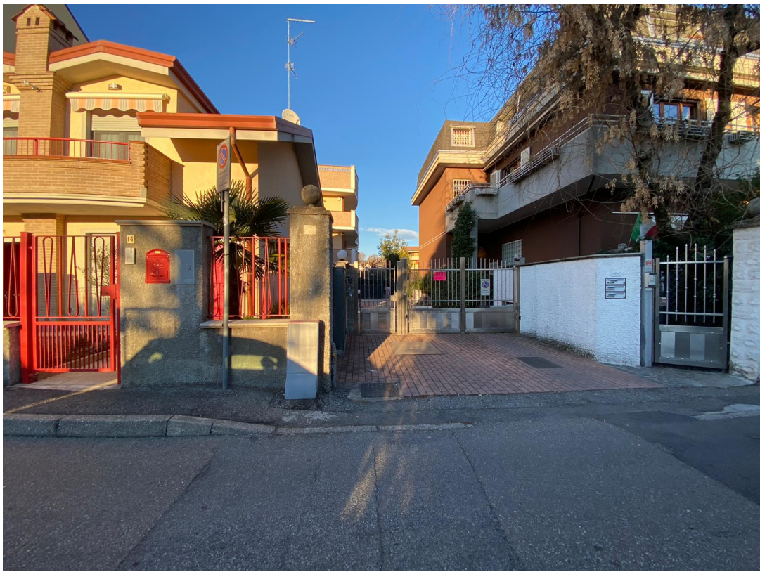
Foto n. 1 – Ingresso al fabbricato
