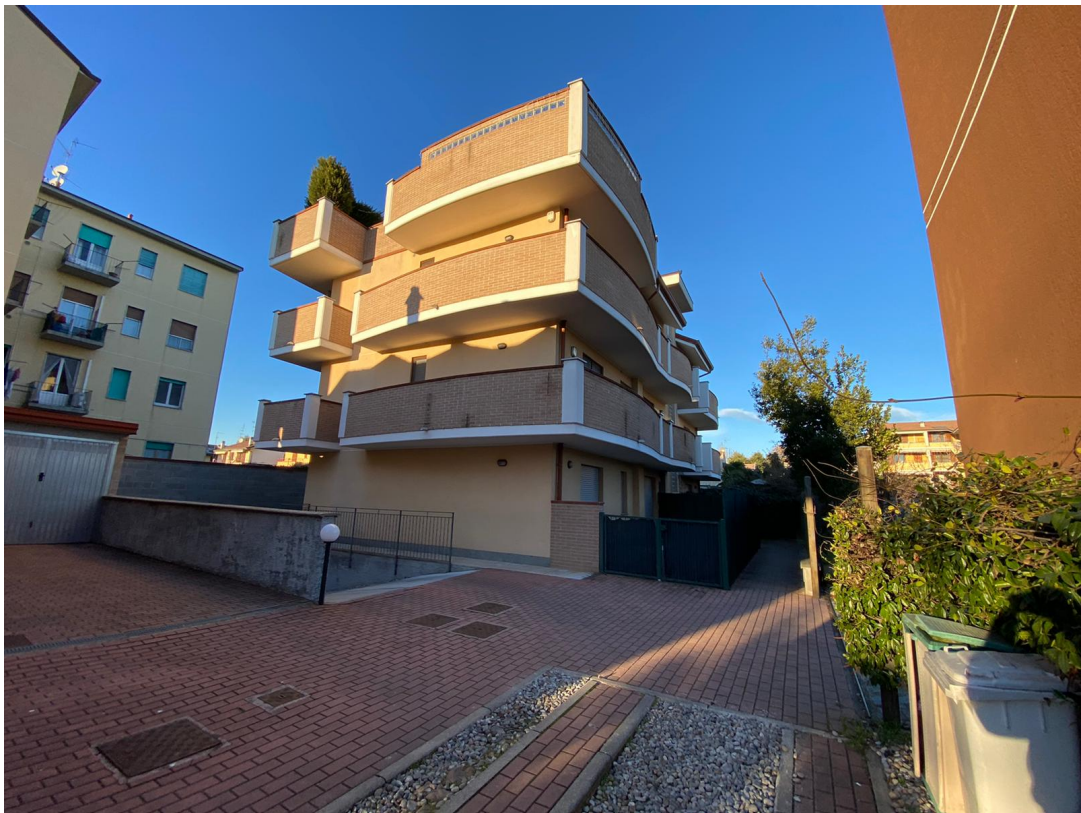
Foto n. 2 – Prospetto del fabbricato
